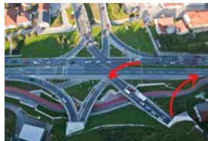
Predor - Dokončanje po 15 letih - Vir: n1info.si
