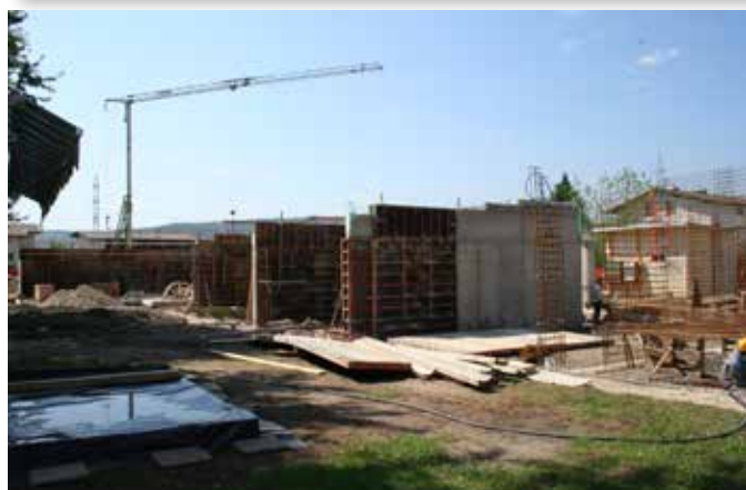
Gradnja nove enote Mravljincek na Brodu (Vrtec Šentvid)
